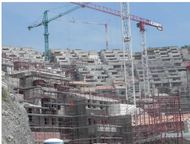
Fase di cantiere
