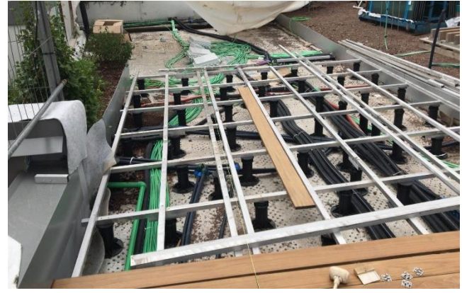
Connessione tra il pavimento galleggiante e il verde pensile
