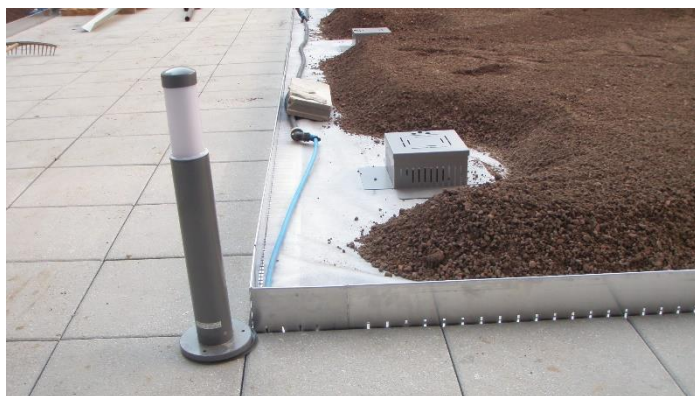
Posizionamento pozzetto di scarico
